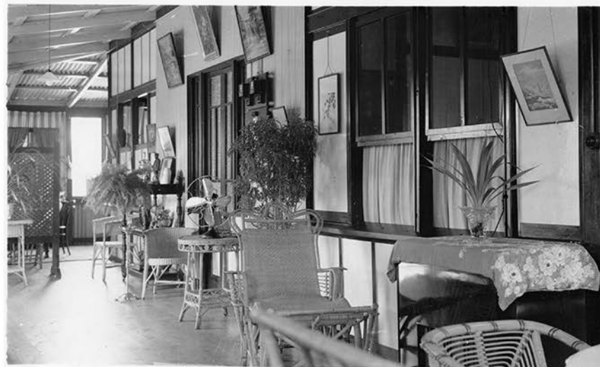
29. ダーウインの家のサイドベランダ、1938年10月24日撮影(木下家所蔵) / Side verandah of the house in Darwin, 24 October 1938. (Courtesy of the Kinoshita Family)
