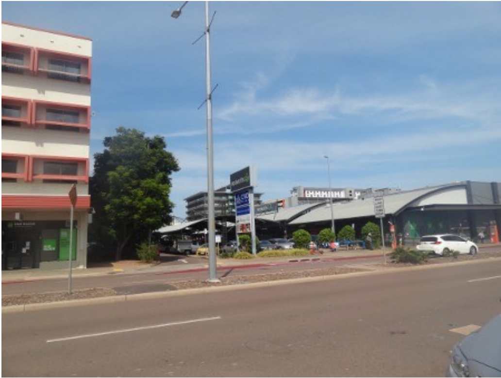
村松居宅跡地：384 キャバナー通り、ダーウィン（2022年9月村上雄一撮影） / Site where Muramats' house once stood: 384 Cavenagh St, Darwin (Photo: Yuichi Murakami, September 2022)
